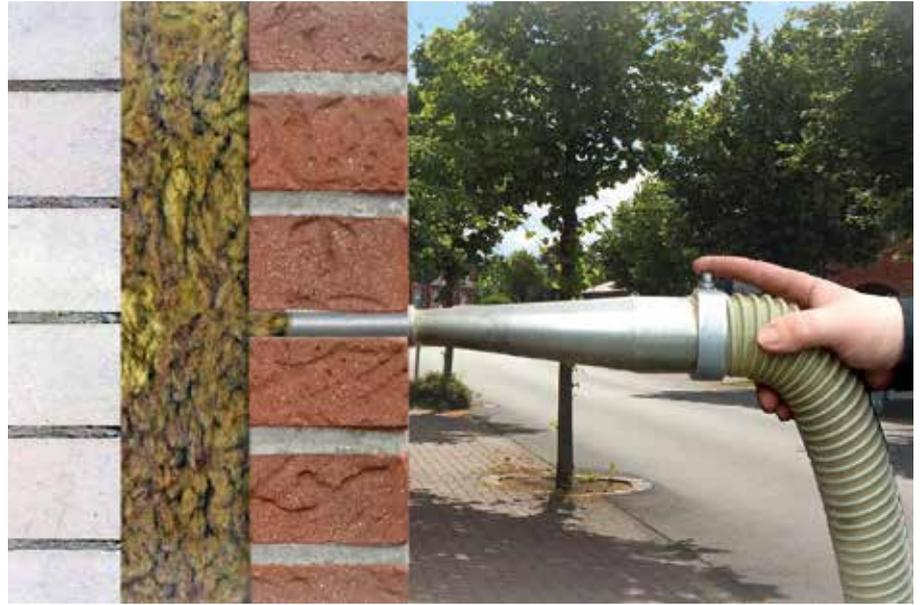
Ohne große Öffnung von Bauteilen lassen sich die Einblasdämmstoffe schnell und verdichtet via Luftdruck in Hohlräume einblasen. (Fotos: epr/Ecofibre.de)
